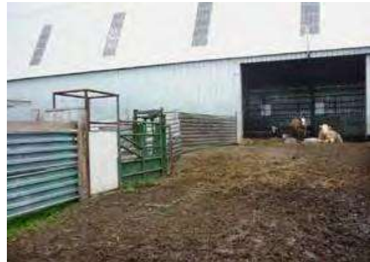
Photo 50 – Corral avec parois pleines construit près du bâtiment de service
