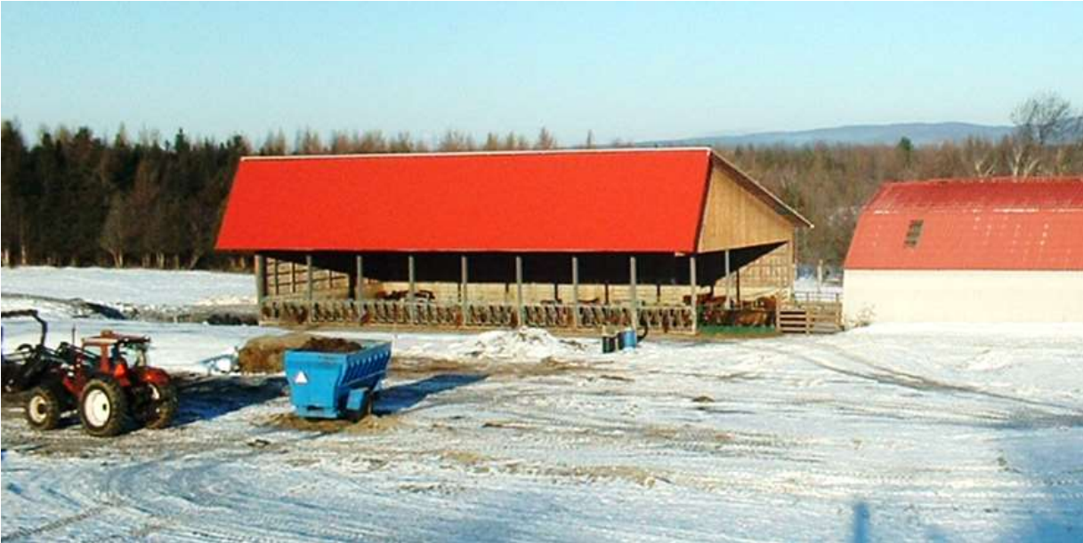
Photo 8 – AAC de type étable froide faite d'une structure en acier-bois. À droite: le bâtiment de service. Non visible à l'arrière: l'enclos d'hivernage de la figure 6.
