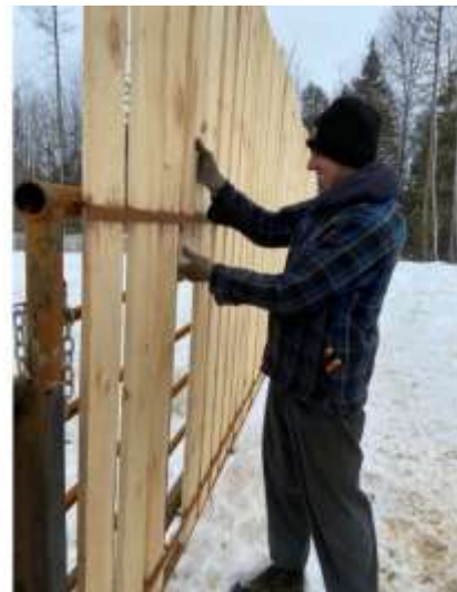
Photo 39 et Photo 40 – Exemples de brise-vent mobiles faits d'une structure d'acier dans laquelle on glisse les planches
