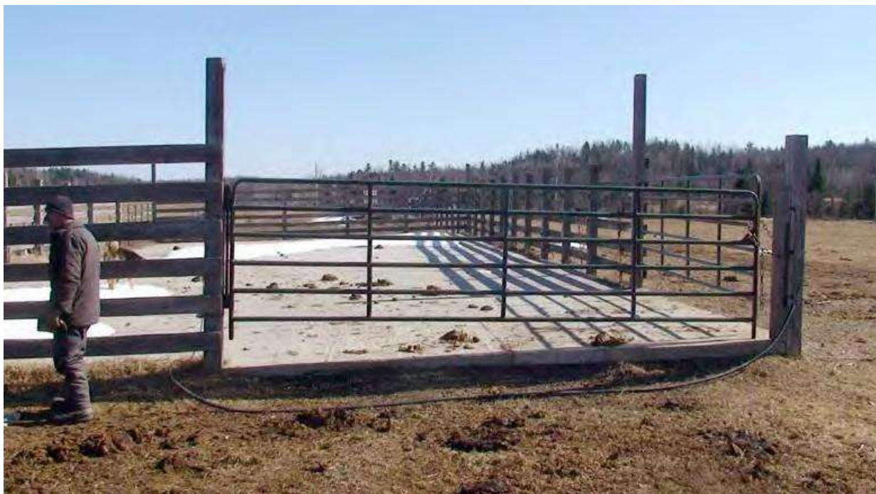
Photo 5 – Aire d'alimentation bétonnée faisant partie de l'aire à portance améliorée.
