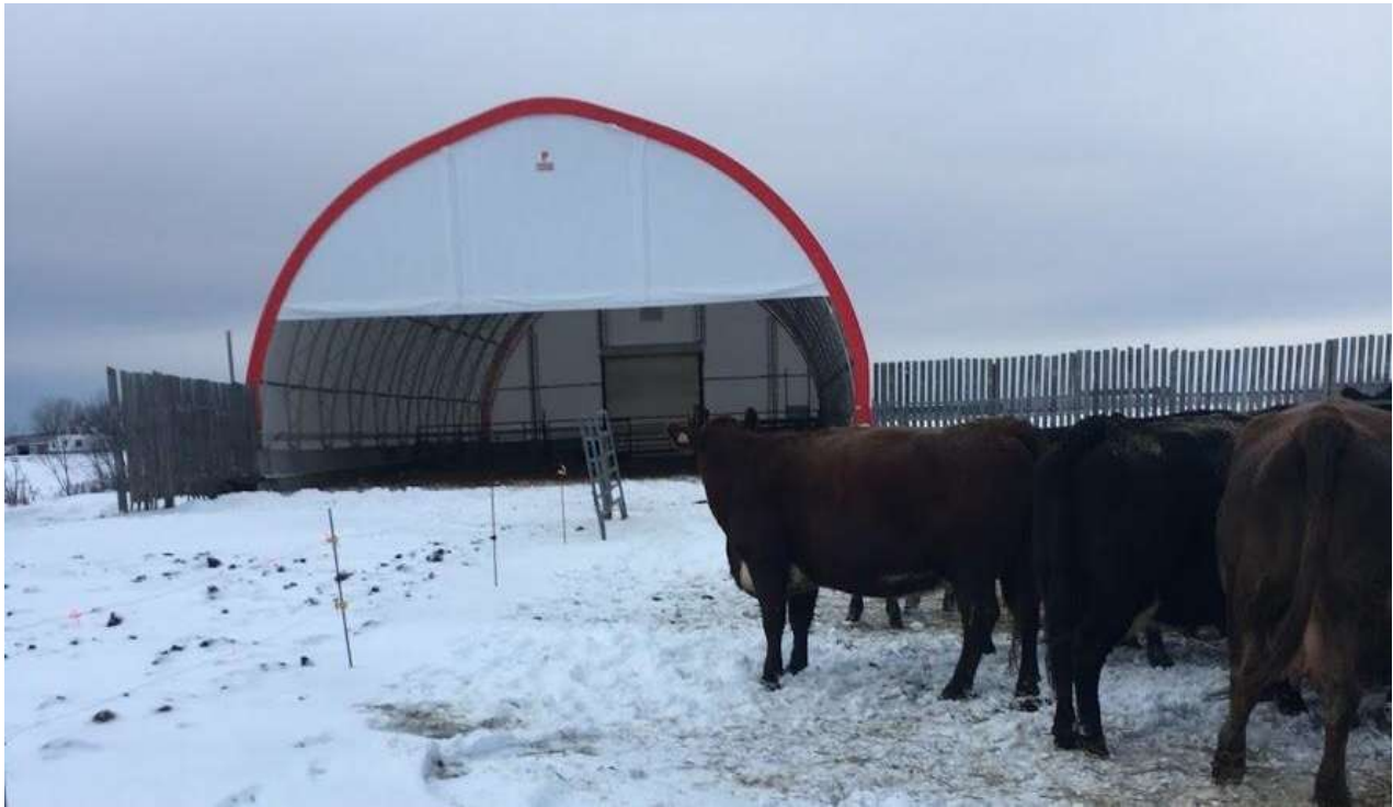
Photo 10 – Exemple d’une AAC avec un dôme en toile déposé sur des murets de béton
