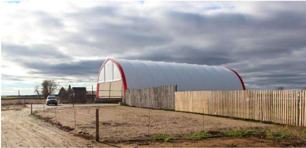
Photo 7 – Vue de l’aire à portance améliorée en sable juxtaposée à l’aire d’alimentation couverte. La transition entre les deux aires se fait sur une dalle de béton.
