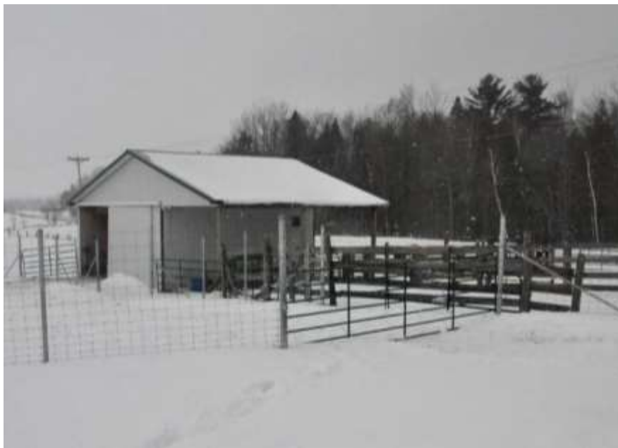
Photo 55 – Bâtiment de service près des enclos utilisé pour les vêlages et la manipulation des animaux.
