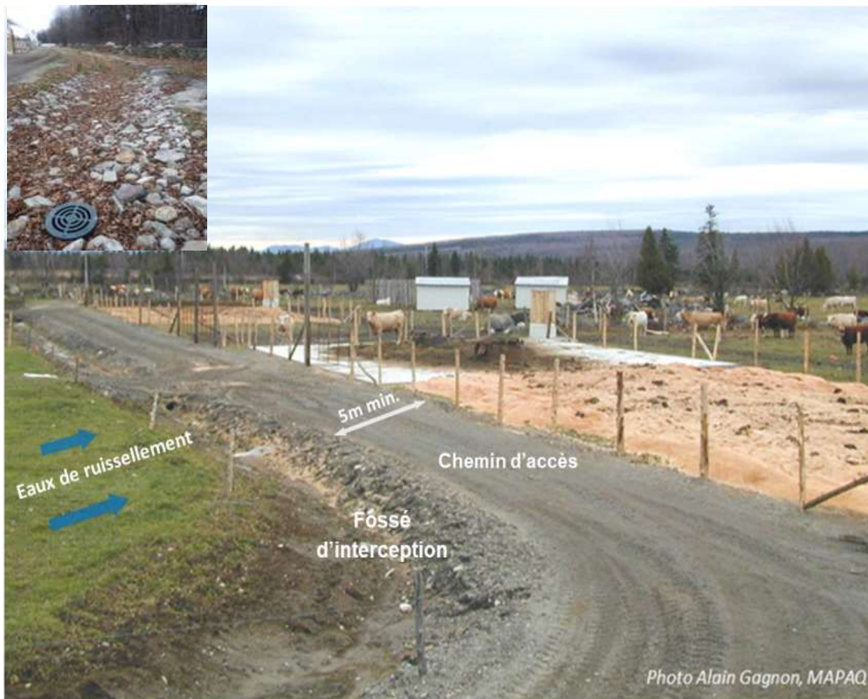
Figure 6 – Fossé d'interception et chemin d'accès (servant également de risberme), situés en amont de l'enclos.
