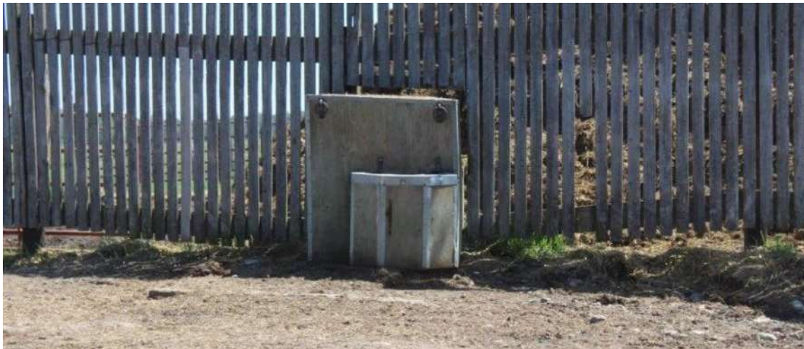
Photo 41 – Abreuvoir chauffant au propane installé le long du brise-vent fixe
