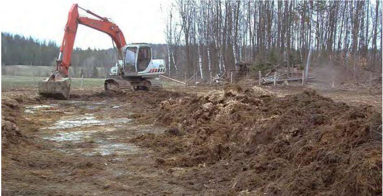
Photo 65 – Grattage des fumiers à l'aide d'une pelle mécanique
