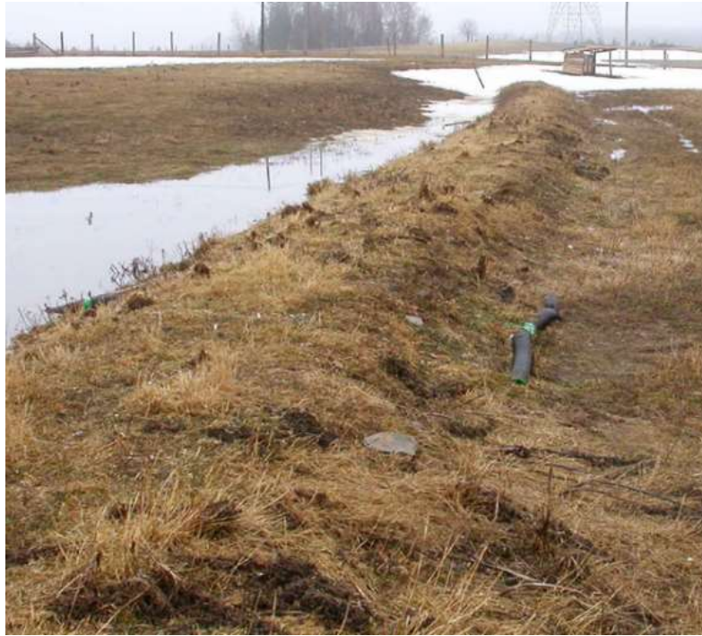
Photo 13 – Risberme avec baissière en aval de l’enclos
