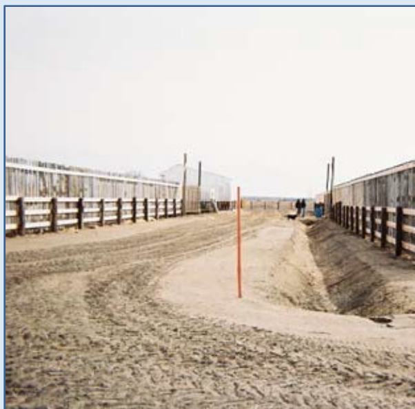
Voies d'accès et fossé de drainage des enclos
