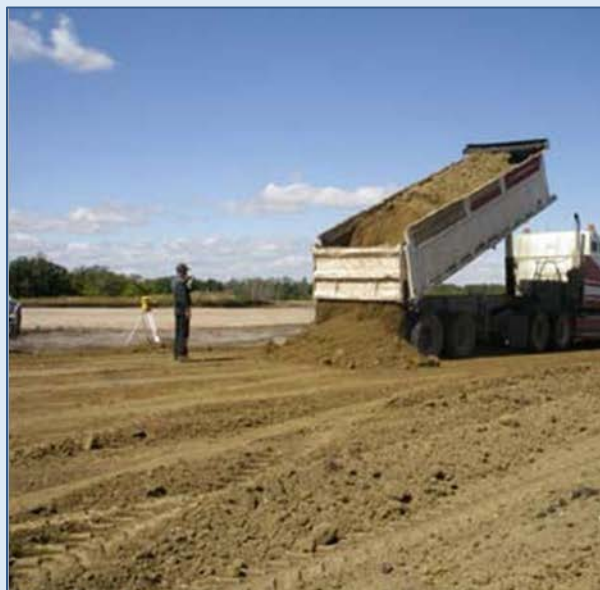
Pour construire l'assise des enclos, il a fallu arpenter et poser une couche d'argile comme fondation de la surface
