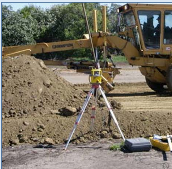
Pour construire l'assise des enclos, il a fallu arpenter et poser une couche d'argile comme fondation de la surface
