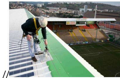
Figure 21 — Installation de polycarbonate en hauteur sur une serre
