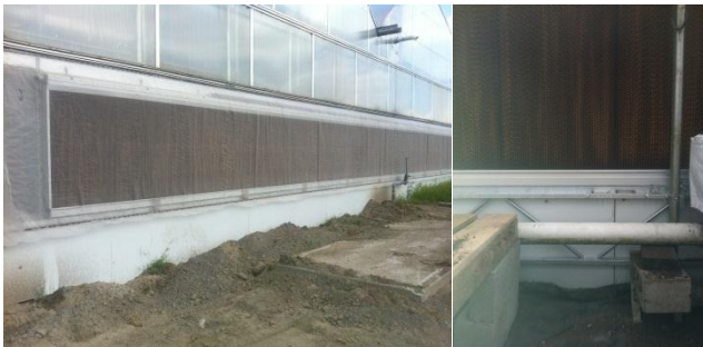
Figure 14 — Schéma d'utilisation des <<cooling pads>>
