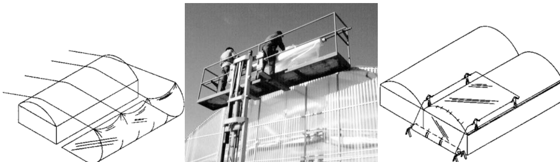
Figure 18 — Technique de mise en place des plastiques de serres
