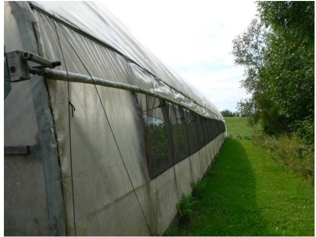
Photo 8 : Serre-tunnel équipée de moustiquaires sur les côtés ouvrants.
