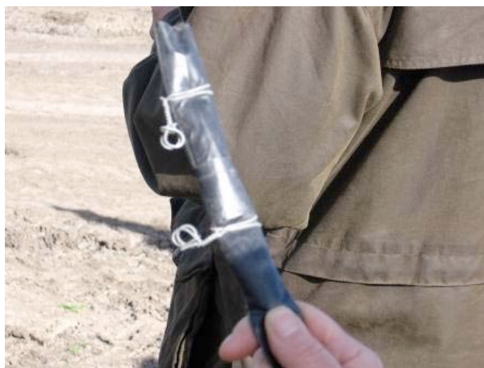
Figure 1 - Raccordement de deux sections de tuyau goutte-à-goutte
