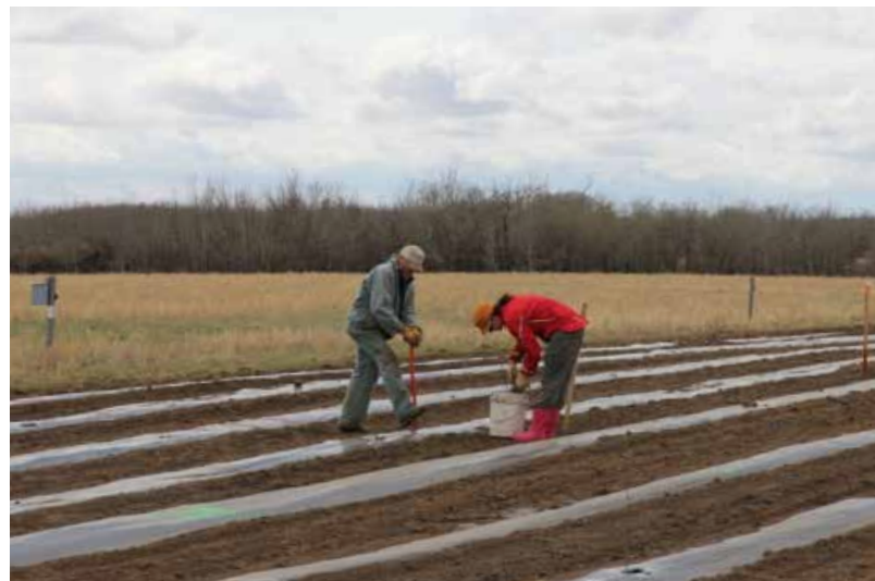
Figure 29. Paillis plastique installé sur un terrain nouvellement préparé pour l'aménagement d'une zone de végétation tampon – M. Wonneck
