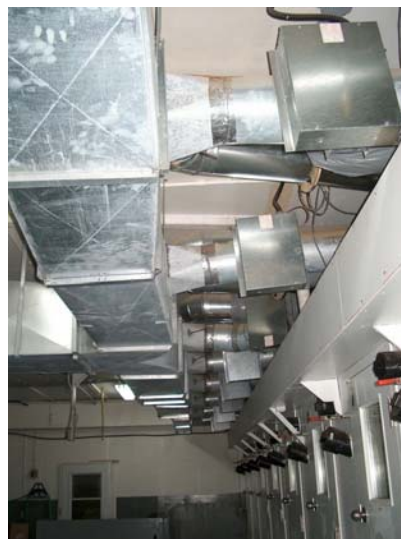
Figure 8 : Circuit de ventilation et de chauffage
