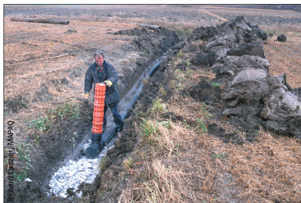
Figure 3. Aménagement d'une bande riveraine arbustive sous paillis plastique et d'un avaloir par la Coopérative de solidarité de la rivière aux Brochets.
