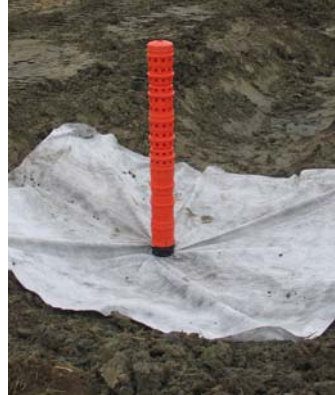
Source: Mikael Guillou (MAPAQ) Installation de la toile géotextile
