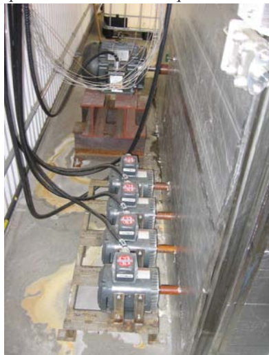
Le système n'utilise que 5 pompes pour son fonctionnement. En haut : la pompe de recompression de vapeur.
