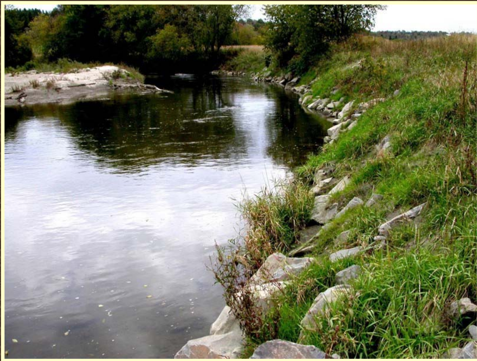
Enrochement et engazonnement, Compton
