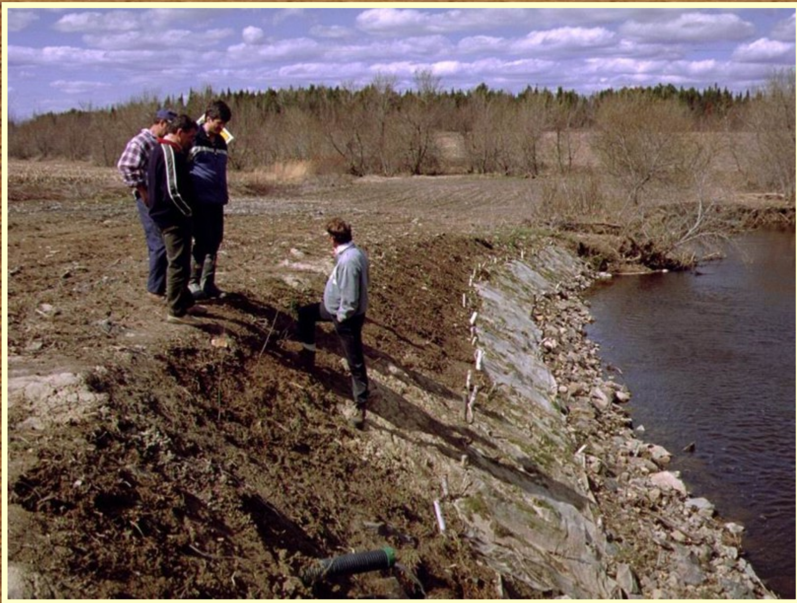
Stabilisation de talus, Montérégie
