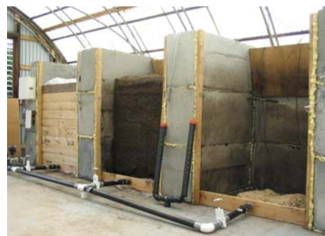
Cellules de conditionnement
