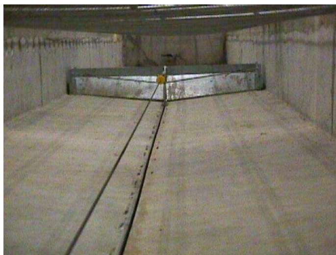
Figure 1 : Système de gratte dalot de la porcherie de l'Université du Michigan
