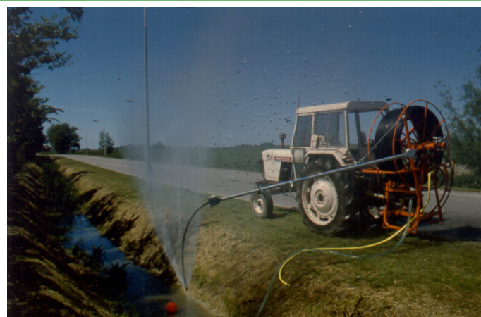
Un nettoyage régulier du système de drainage est un des moyens pour en prolonger la durée.
