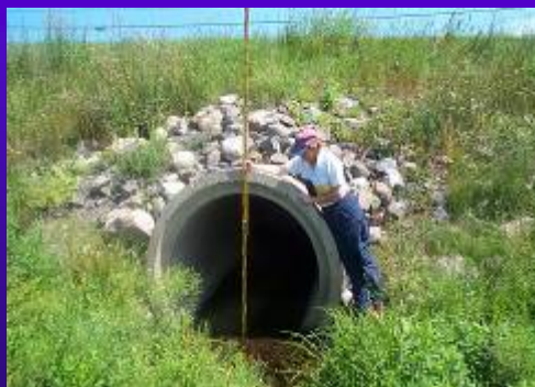
Ponceau (diamètre < 3,6 m)
