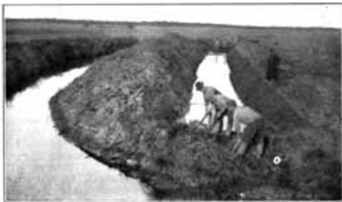
Redressement fait à la pelle à main. Le coût initial sera facilement remboursé par l'économie réalisée dans l'entretien du cours d'eau.
