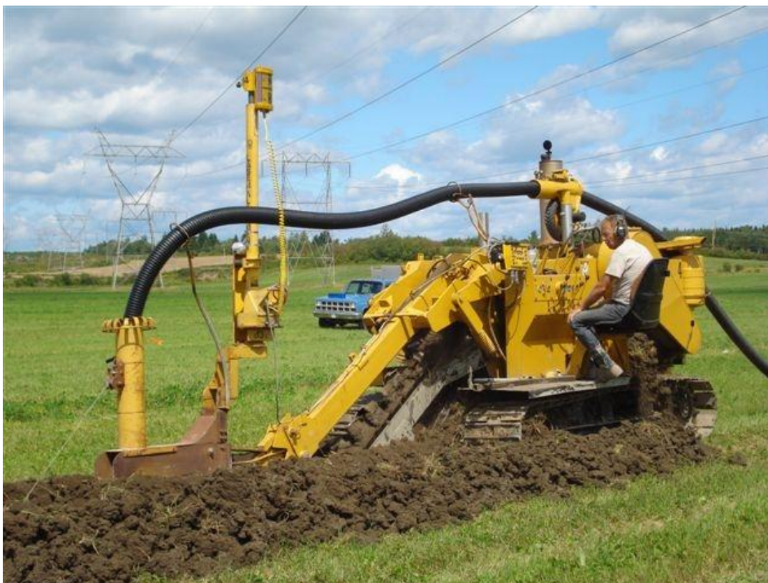
Photo 4 : excavatrice à chaîne pour argile sensible et terre noire
