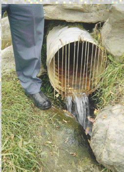
Sortie de drain empierrée
