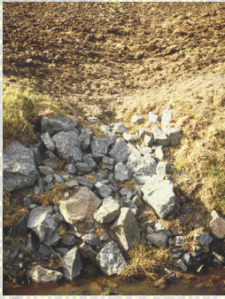
Sortie de fossé empierrée
