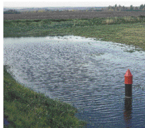
Bassin de captage des eaux de ruissellement
