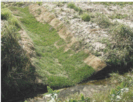
Sortie de fossé engazonnée en plaques
