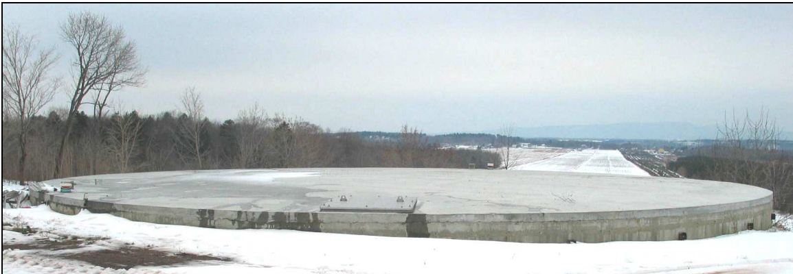
Figure 1. Toiture étanche en béton
