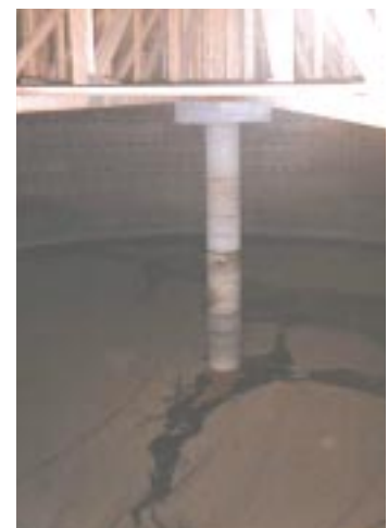
Vue du pilier de béton central et des demi-fermes s'y appuyant.
