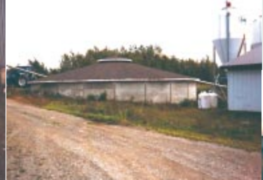
Réservoir constitué de demi-fermes triangulaires, de contreplaqué et de bardeaux l'asphalte.
