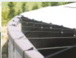
Courroies de nylon horizontales installées pour supporter la toile.
