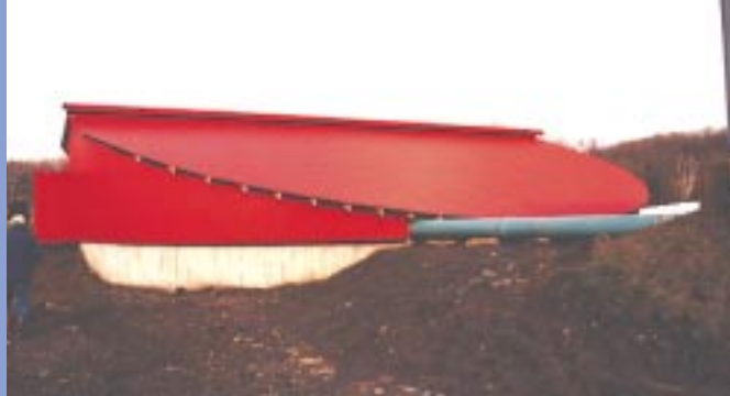
Toiture constituée de tôle et fermes triangulaires de largeurs variables.
