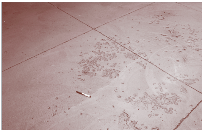
Figure 2c - Écaillage sévère d'une dalle de béton
