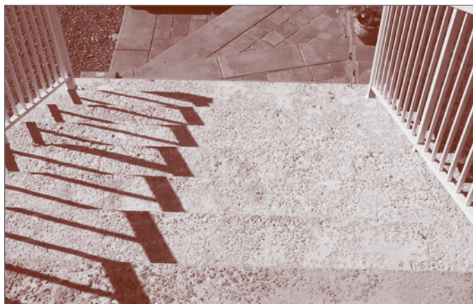
Figure 3c - Écaillage sévère à très sévère d'un escalier de résidence
