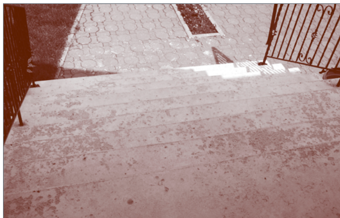
Figure 3c - Écaillage sévère à très sévère d'un escalier de résidence
