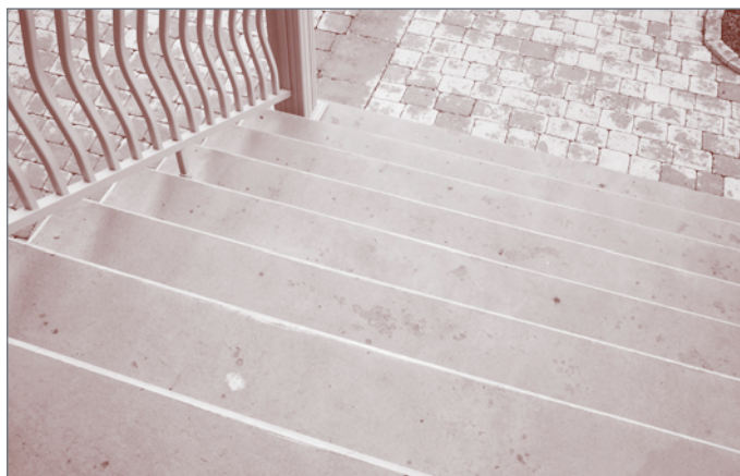
Figure 3b - Écaillage modéré d'un escalier de résidence
