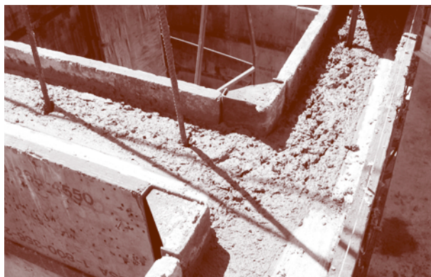
Figure 6 - Durcissement du béton frais dans les coffrages
