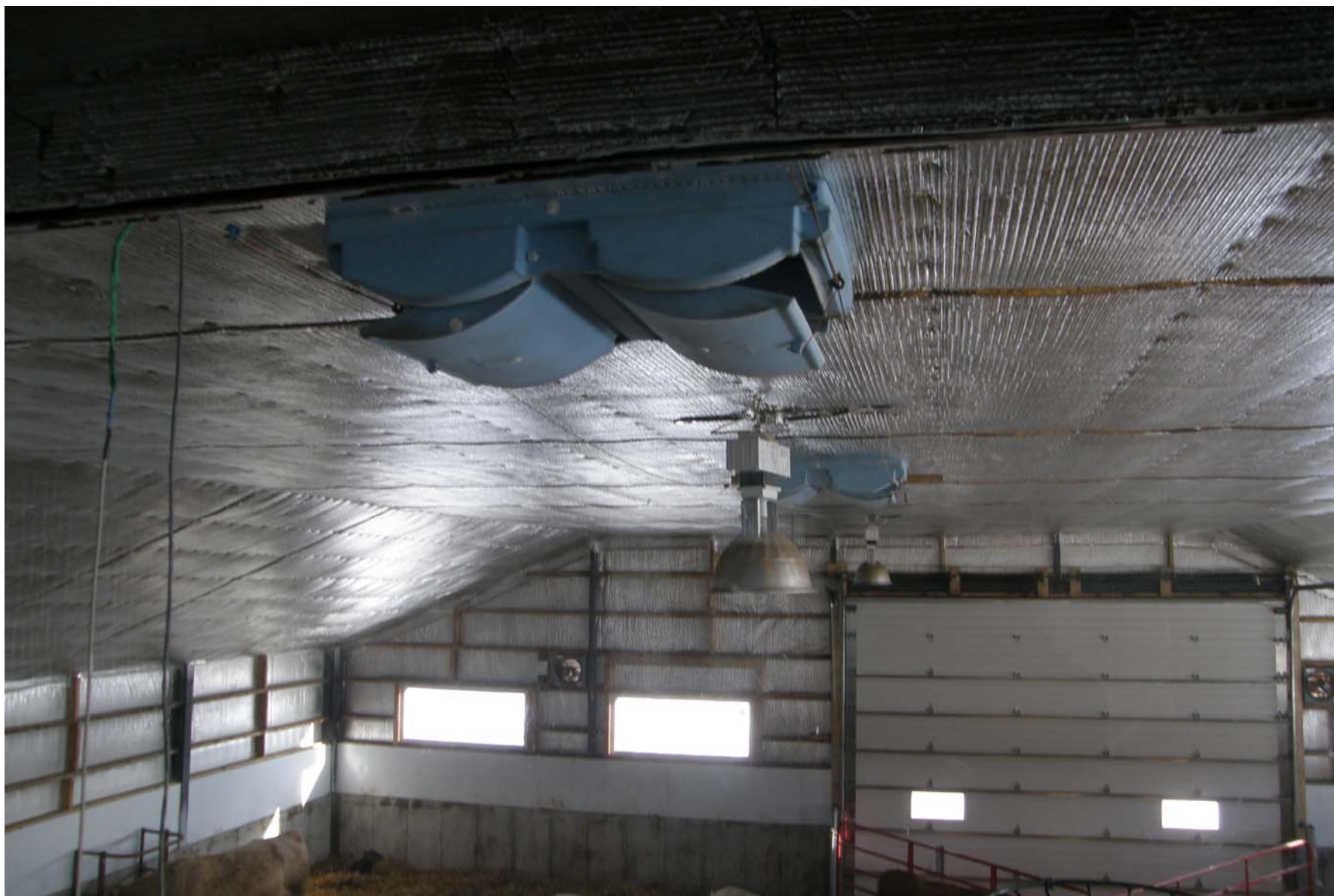
Figure 7 : Trappe d'air de type plafonnier dont l'ouverture est contrôlée par un treuil manuel.
