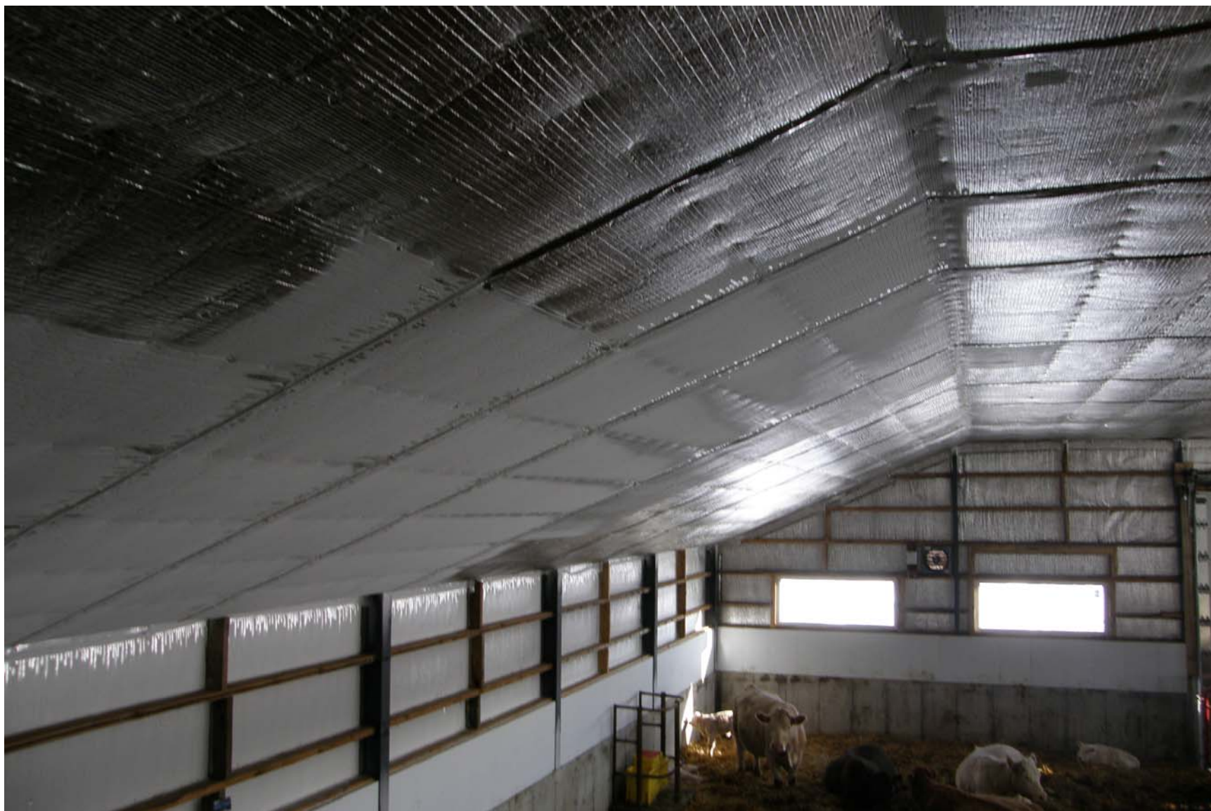
Figure 6 Photo prise à la mi-décembre. On remarque clairement la présence de givre sur certaines surfaces du plafond qui n'ont pas encore été isolées avec la laine de 3,5". Dans les jours qui ont suivi, l'isolation a été complétée sur tout l'entre-toit faisant passer l'isolation globale du bâtiment de R4,14 à R11,8.
