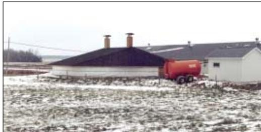
Toiture en bardage d'asphalte (catégorie bois-asphalte)
