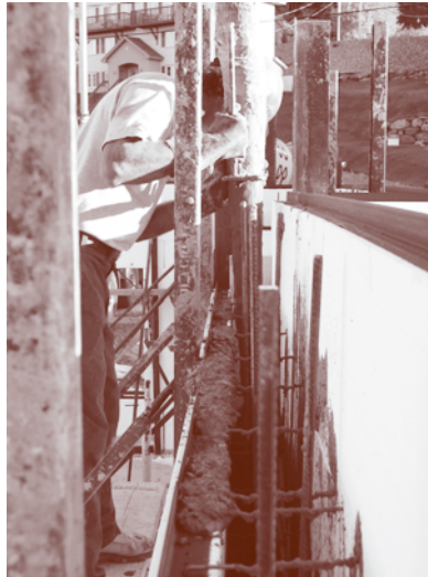
Figure 4 - Fondation résidentielle en coffrage isolant
