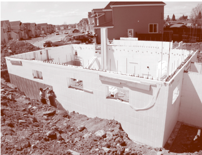
Figure 4 - Fondation résidentielle en coffrage isolant
