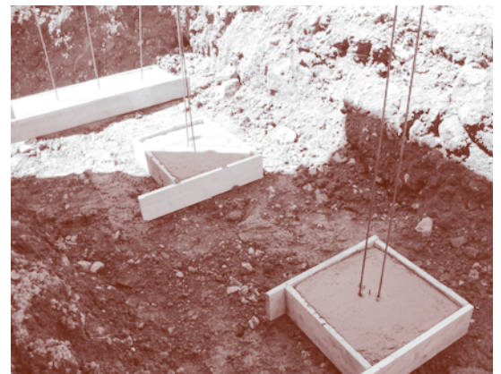
Figure 1 - Semelles reposant sur un sol non remanié
