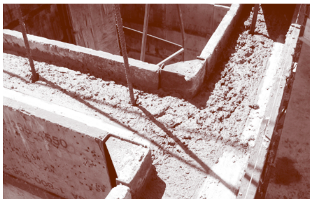
Figure 6 - Durcissement du béton frais dans les coffrages
