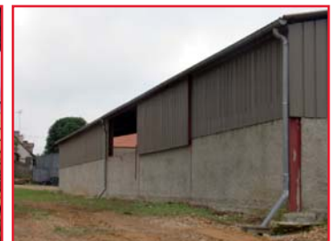
Photos 6 et 7 : Libre-service arrière aménagé à l'intérieur de la case avec approvisionnement depuis le long pan grâce à un panneau de bardage coulissant
