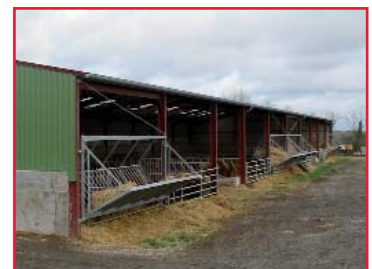
Photo 9 : Râtelier suspendu de grande capacité qui nécessite une charpente adaptée
