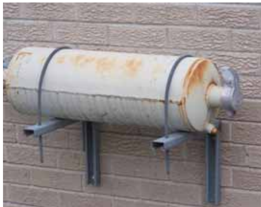
Photo 6. Clapet d'échappement d'une pompe à vide
