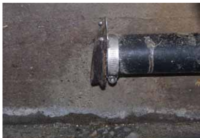
Photo 4. Clapet du dessous du réservoir de vide
