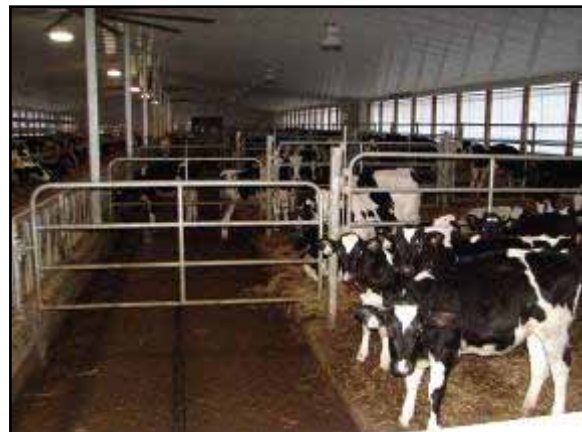
Photo 4. Allée de nettoyage plancher incliné
