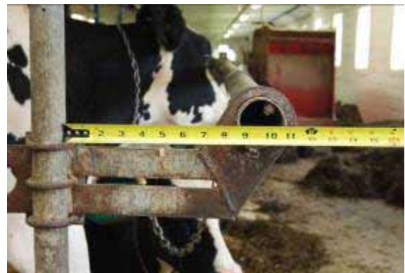
Photo 4. Distance entre le muret et la barre d'attache de (20 cm ou 8 po)
