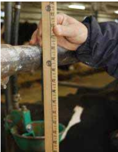
Photo 3. Hauteur 122 cm (48 po) de la barre d'attache des vaches en lactation
