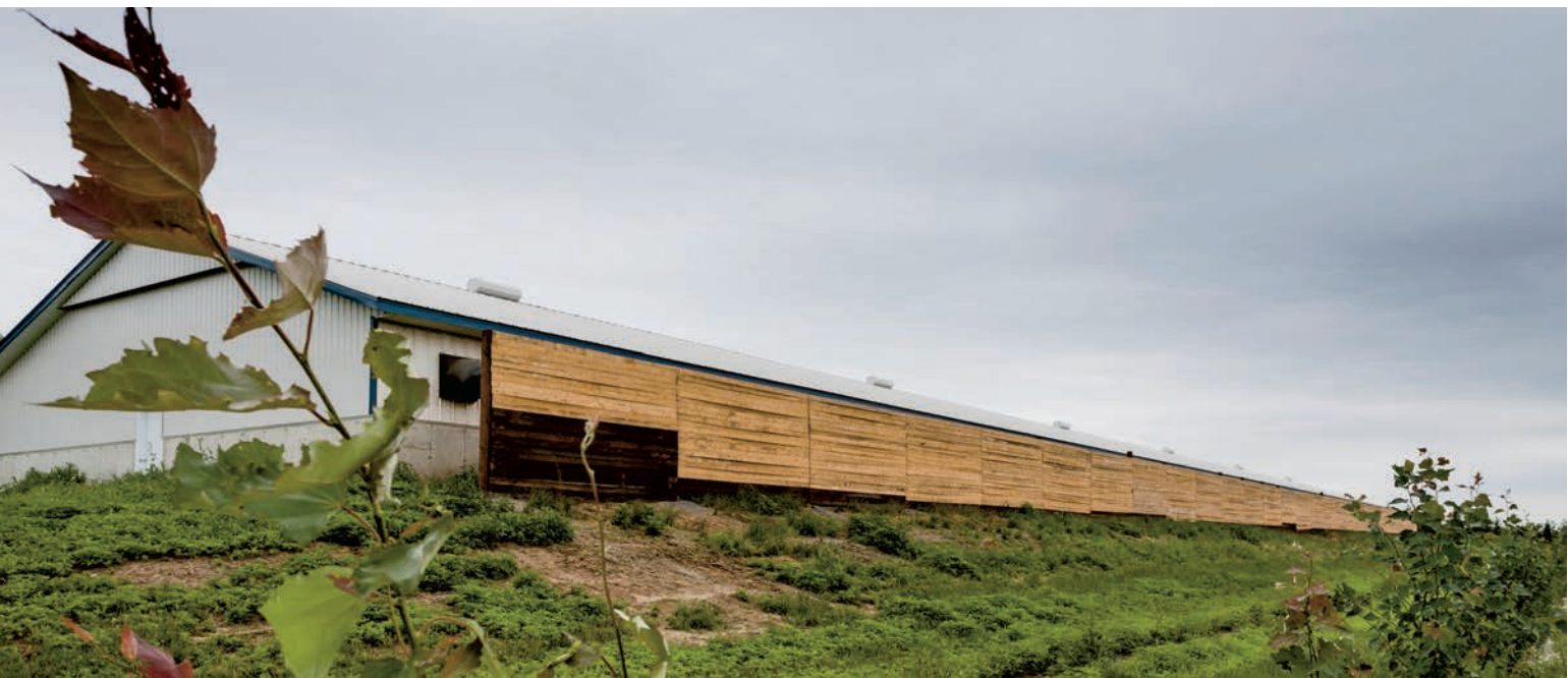
Une palissade en bois a été érigée pour réduire le bruit émis par les ventilateurs du bâtiment d'engraissement et des arbres ont été plantés.
