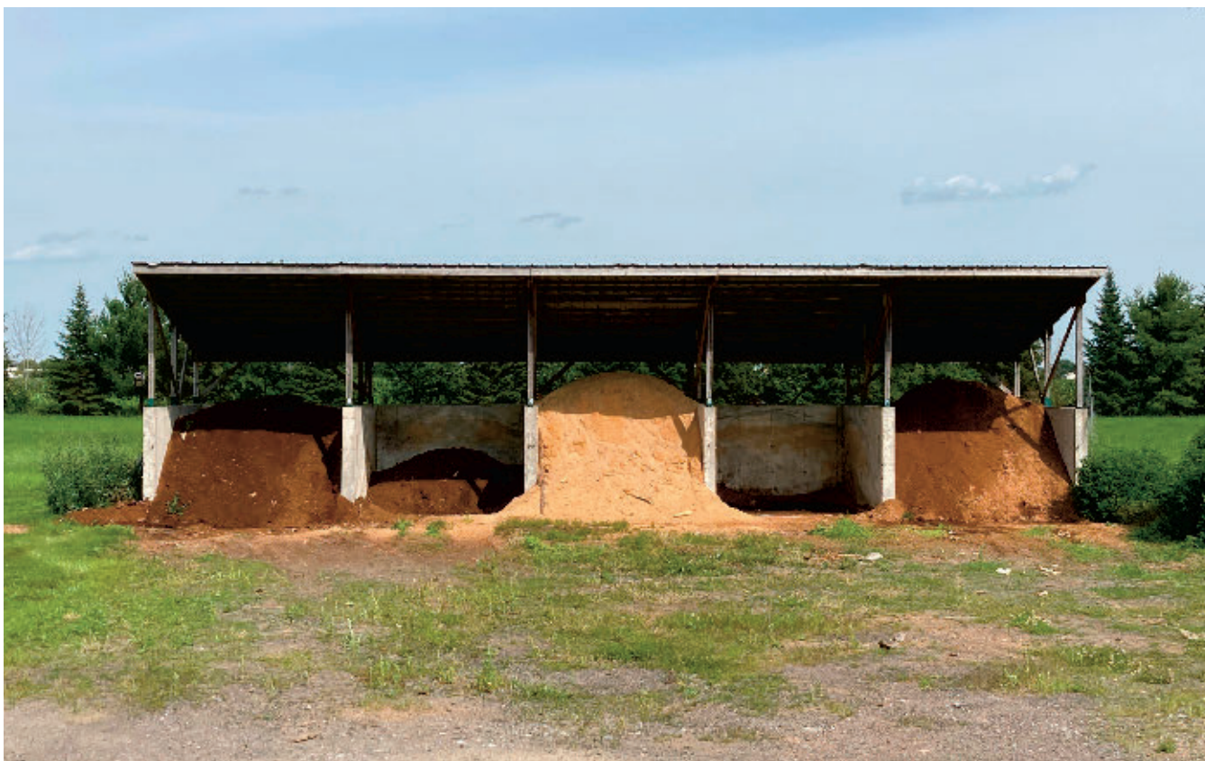
Quatre cellules servent au compostage, tandis qu'une sert à entreposer la sciure de bois, matière favorisant le compostage des animaux.
