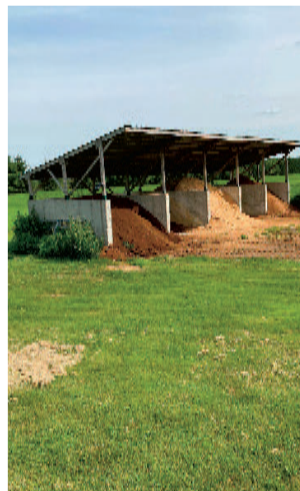
La structure comportant les cinq cellules est en béton.
