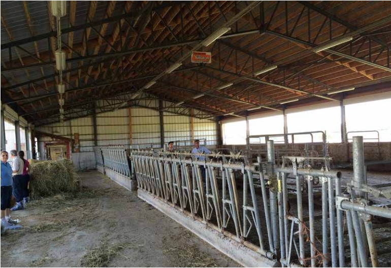
Étable froide pour les sujets de remplacement avec aire d'alimentation, aire de nettoyage et aire de couchage
