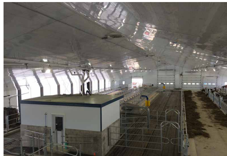
Vue d'ensemble de l'étable
