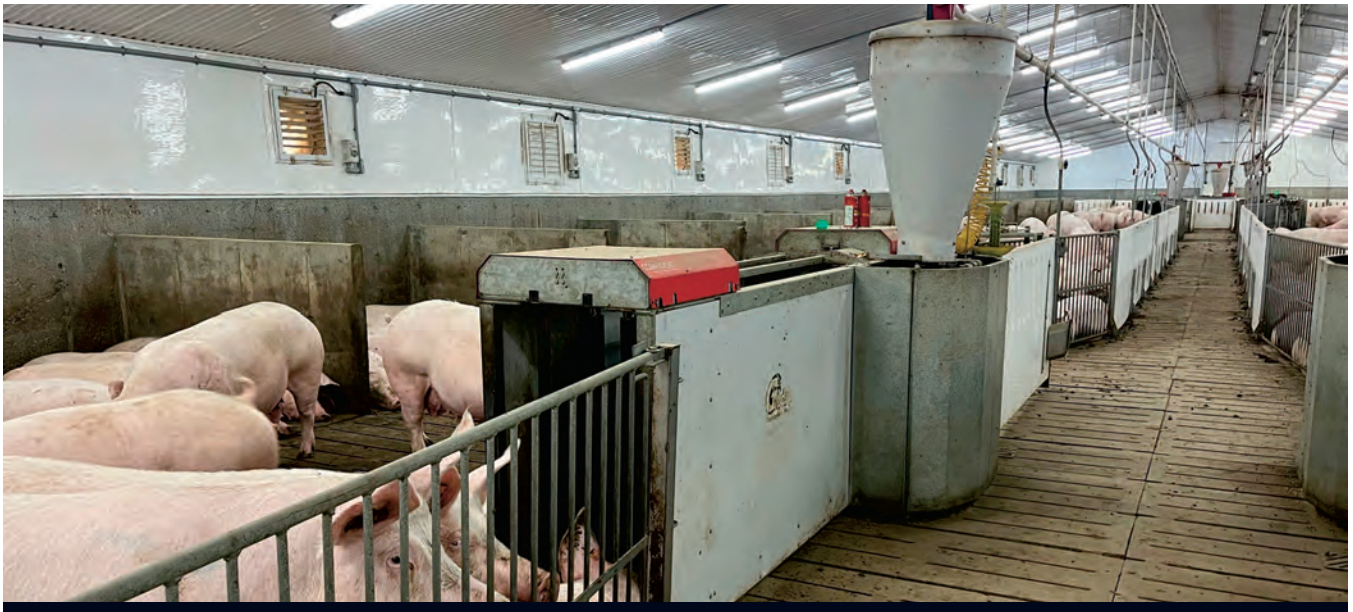
Dans le système choisi par l'éleveur, une truie entre par une porte et sort par une autre. Au passage, la puce électronique apposée sur la truie est détectée par le logiciel du système d'alimentation qui peut lire les données sur l'animal et lui donner ainsi sa propre ration.
