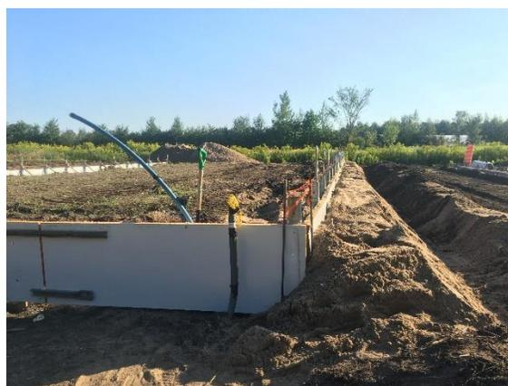
**Image 2. A) Serre froide et B) Isolation du pourtour de la serre avec des cœurs de porte à l'INAB (photos CETAB+).**
