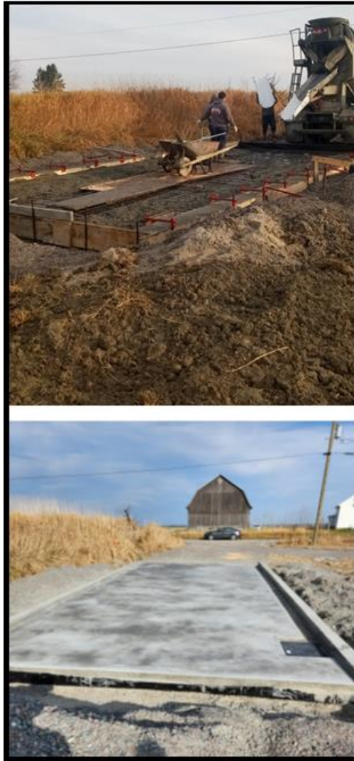
Figure 9. Construction de la station permanente. Pendant (Haut) et après (Bas) les opérations.
