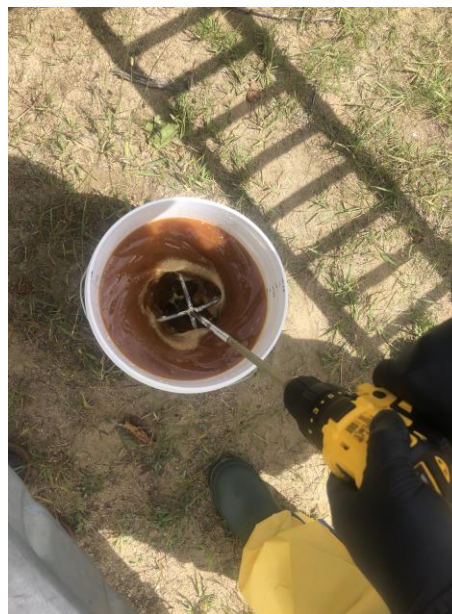
Figure 5. Mélange de la bouillie à l'aide d'une perceuse munie d'un mélangeur à peinture.
