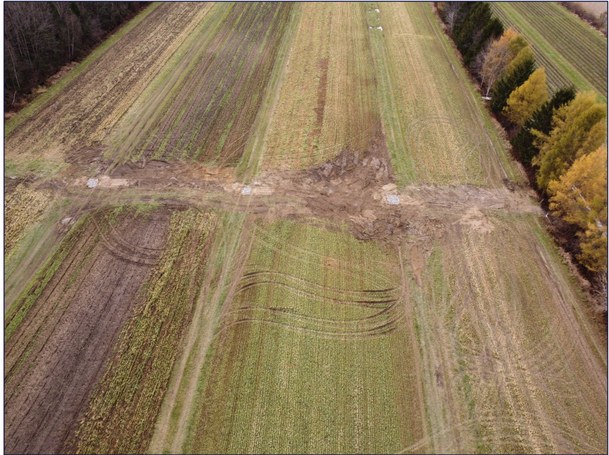
Ex. : aménagement de puits filtrants à l'intersection raie de curage – rigole d'interception dans un champ drainé souterrainement
