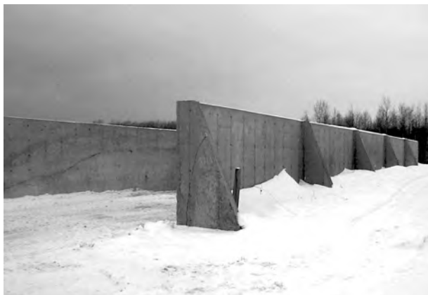
Figure 8. Murs en béton coulés sur place Photo : Luc Dubreuil, MAPAQ
