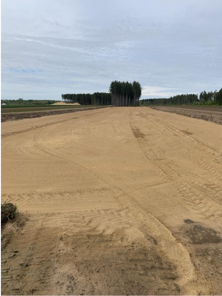
Étape 1: Préparation du site
