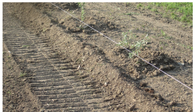
Corde installée parallèlement à une ligne de référence
