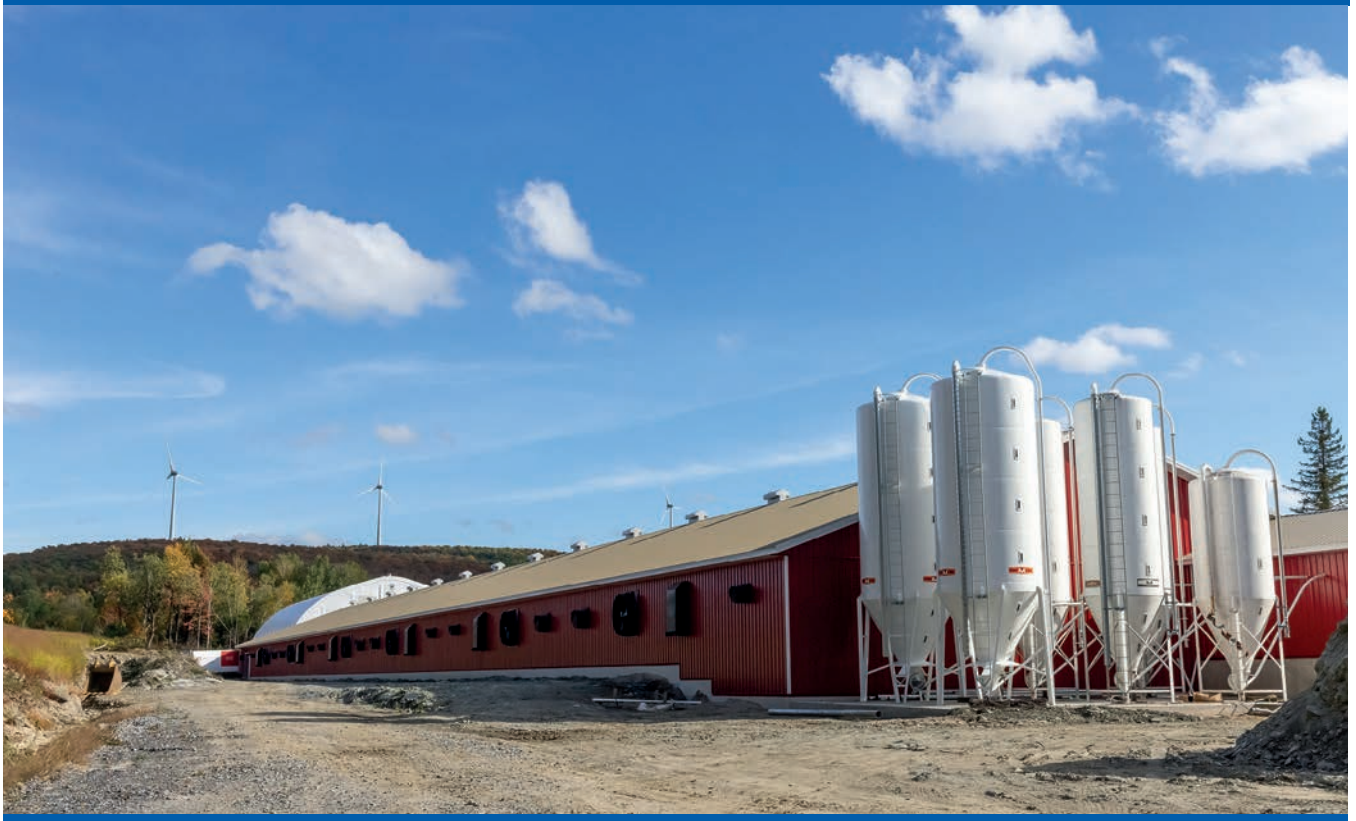
Un des bâtiments des Fermes Rudbeckie en Chaudière-Appalaches.
