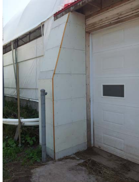
Figure 7: Conduite isolée du côté extérieur qui achemine l'air à l'intérieur
