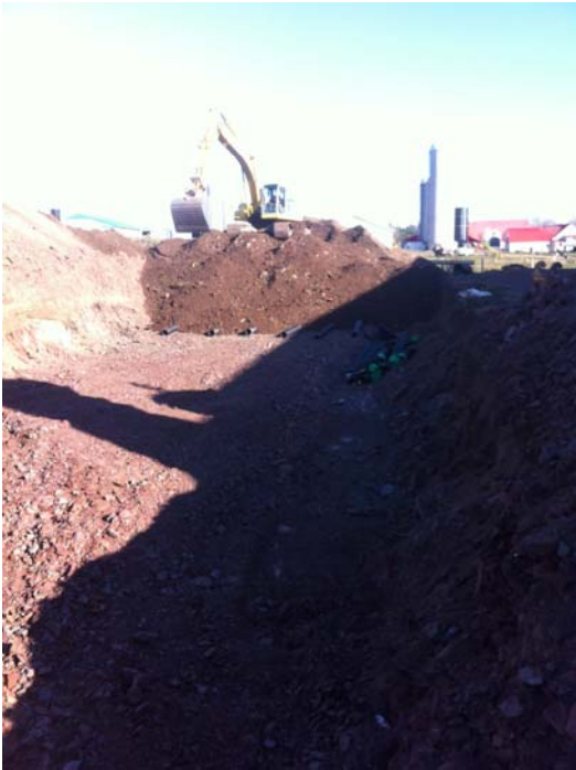
Figure 6 Six (6) Tuyaux de 200 mm de PVC formant le radier du puits canadien. Ces tuyaux étaient raccordés à l'entrée de même qu'à la sortie par un collecteur de 460 mm de diamètre
