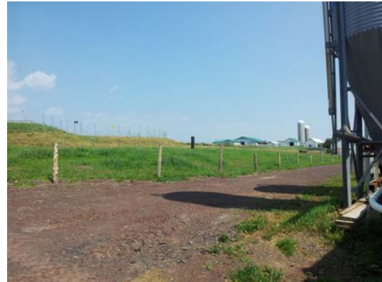
Figure 11: Emplacement du puits canadien après le semis. Noter la cheminée d'entrée d'air de 460 mm de diamètre. Un capuchon et un grillage seront aménagés.
