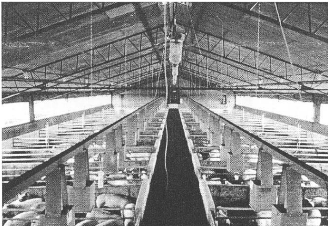
La ventilation naturelle fait régner une excellente ambiance dans ce bâtiment d'élevage climatisé et isolé, à toit à fermes d'acier et plafond en pente.
