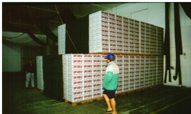
Figure 1. Tunnel de refroidissement par air pulsé conçu pour refroidir deux couches de palettes de fruits à noyau à la fois, dans une station fruitière de la Californie. Le tunnel se trouve
