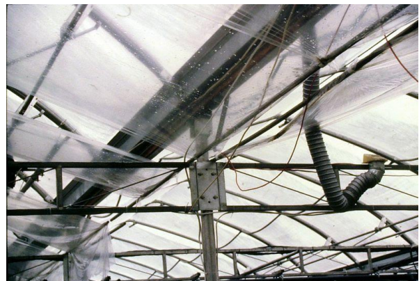
Photo 2 – Films de plastique installés au faite de la serre pour réduire le dégouttement de l'eau de condensation. Source : ©IQDHO
