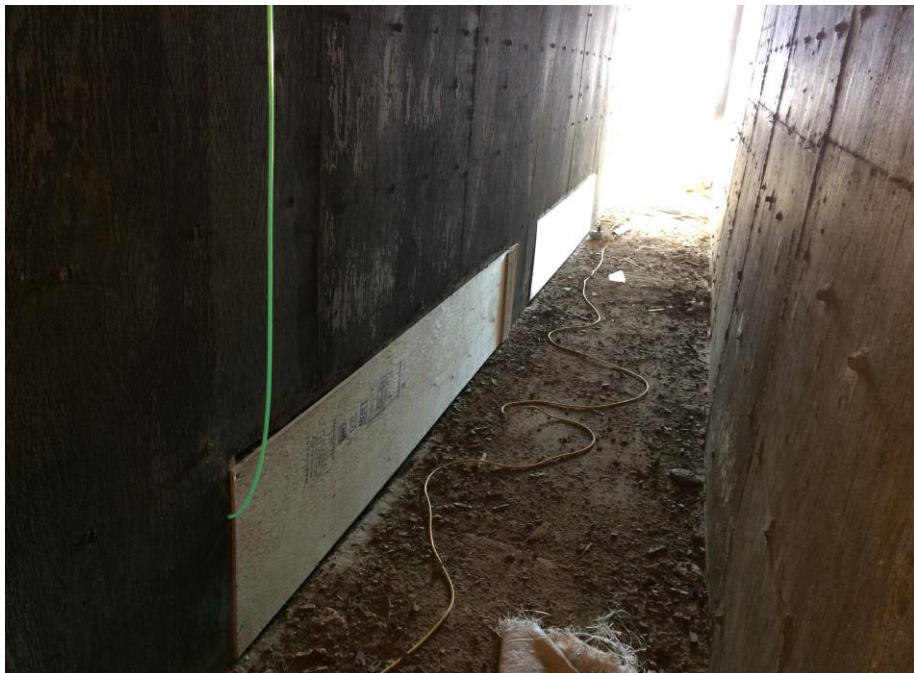
Figure 3 : Vue d'une portion du plénum commun de distribution au moment de la construction avec les clapets de distribution de la cellule # 1. La tubulure de 3/16 po permet la mesure de la pression statique sous la cellule #1.
