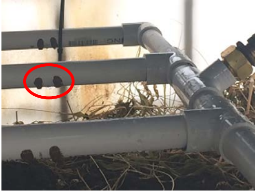
Photo 5 : Perforations à 45 degrés avec traits de silicone (encerclé)
