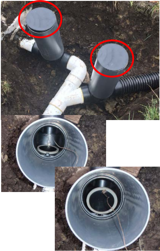
Photo 2 : Tuyaues à la sortie de l'aire de rinçage et clapets antiretour
