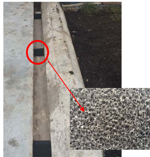
Photo 1 : Caniveau avec bloc de matériaux filtrant
