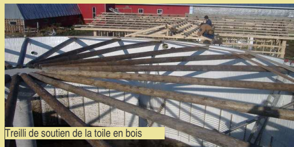
Mur de la citerne fait à partir de formes de styrofoam
