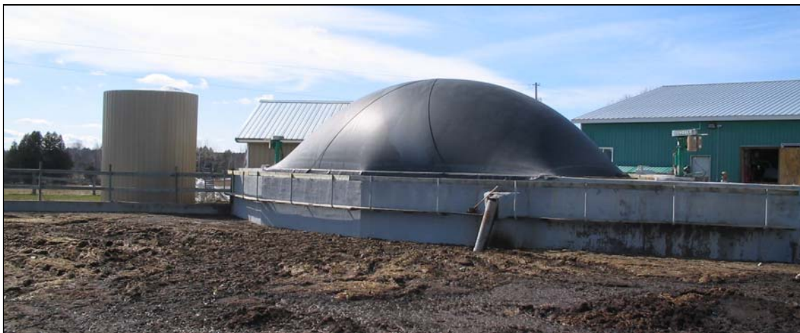
Figure 1. Bioréacteur construit à même la fosse existante
