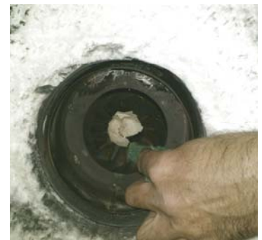
Figure 37 Nettoyage de la tête du brûleur
