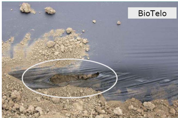
Tension trop grande sur le rouleau durant la pose
